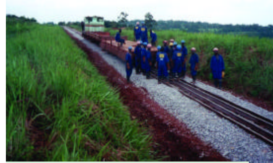
Gleisbauarbeiten bei Jinja - Viktoriasee
